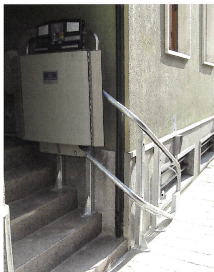
Fissaggio a gradino
